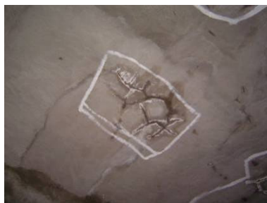
Escarificação mecânica, corte de concreto até 3,0cm de profundidade.
