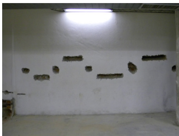
Figura 45 - Foto da prospecção da parede dupla no subsolo
