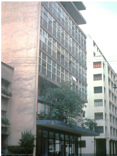
Figura 2 - Marquise sem escoras e com utilização das jardineiras - década de 1950 Acervo IAB-SP
