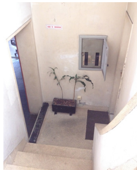
Figura 49 - Quadro de luz e sanitário com acesso pela escada
