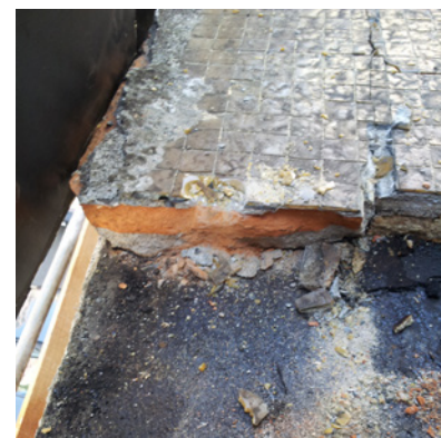
Figura 26 - Camadas sobrepostas do piso
