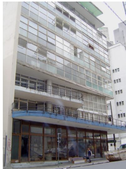
Figura 3 - Marquise sem escoras 2008 Acervo IAB-SP
