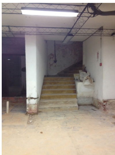
Figura 38 - Subsolo sem piso elevado
