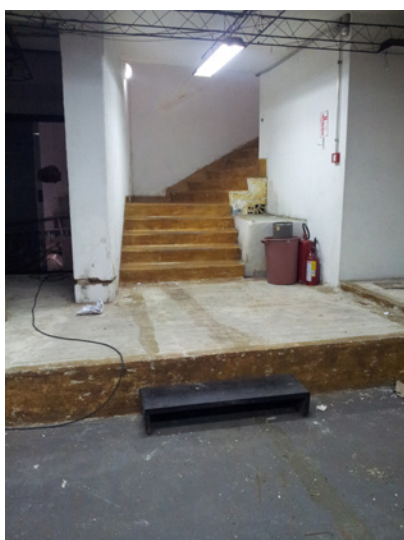
Figura 37 - Subsolo com piso elevado
