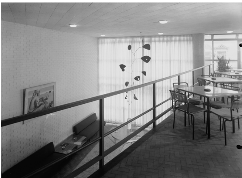
Figura 51 - Alvenaria de tijolos pintada de cor branca - década de 1950 Acervo IAB-SP
