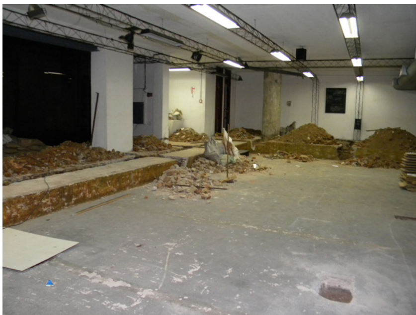
Figura 36 - Prospecção no subsolo - Enchimentos
