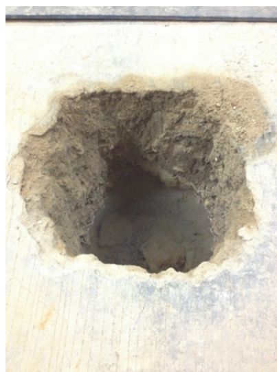
Figura 40 - Prospecção no piso do subsolo
