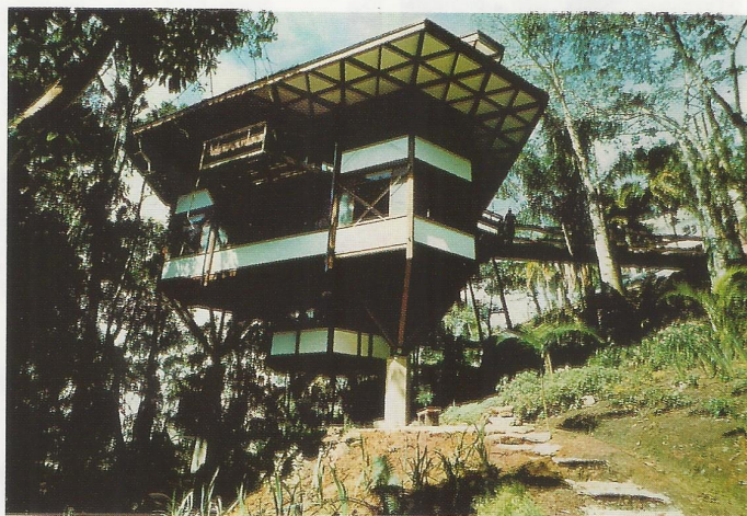
Residência Acayaba, Guarujá-SP Marcos Acayaba
