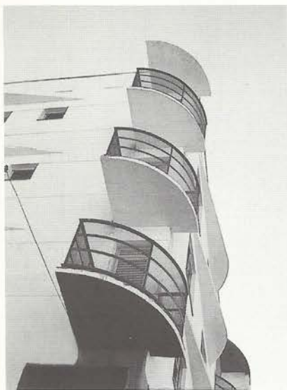
Uberlândia - MG construção 1996
