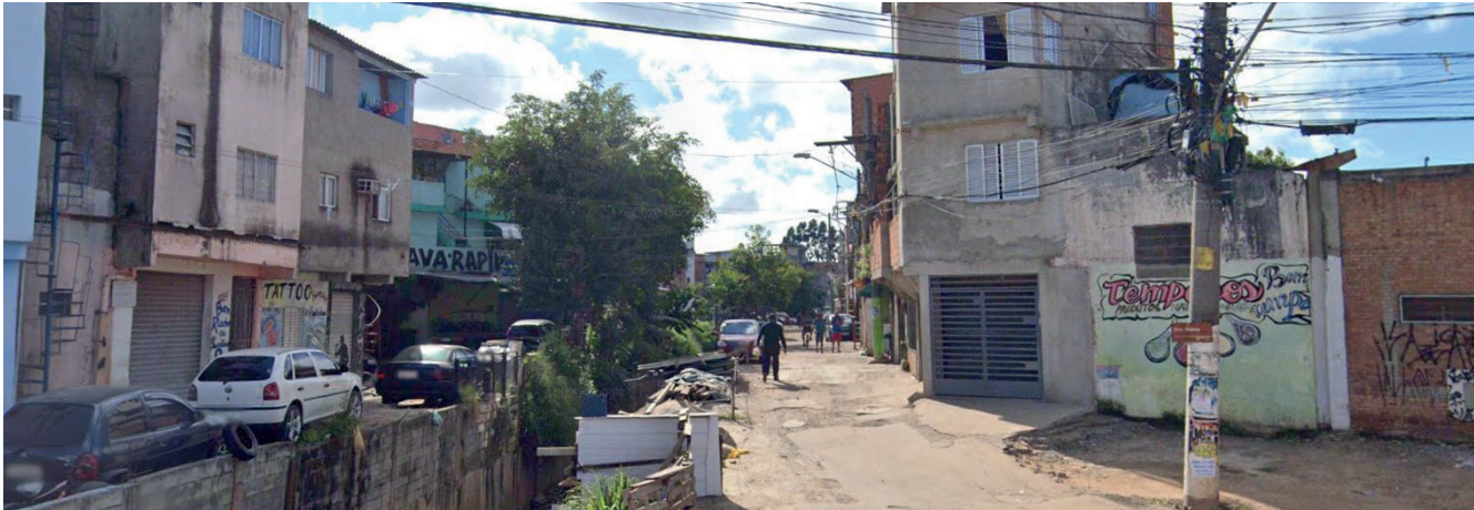
Córrego junto à Rua Bicicleta que demanda por obras de infraestrutura
