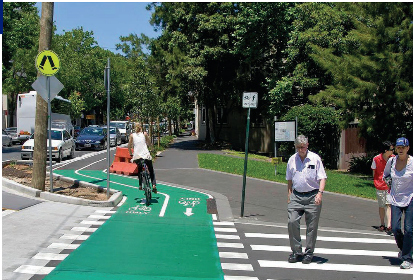
Sinalização horizontal para travessia de ciclista na Ciclofaixa.
